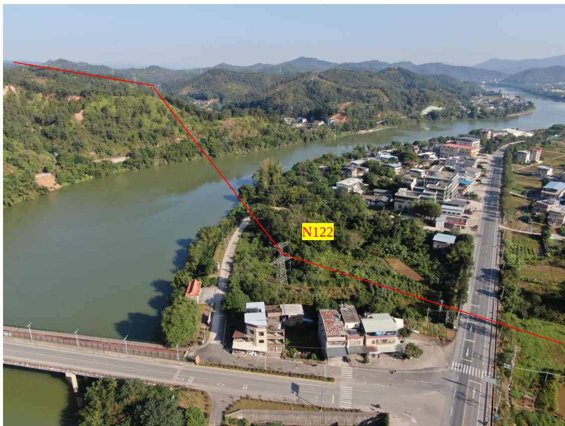
更换导线跨河现状
