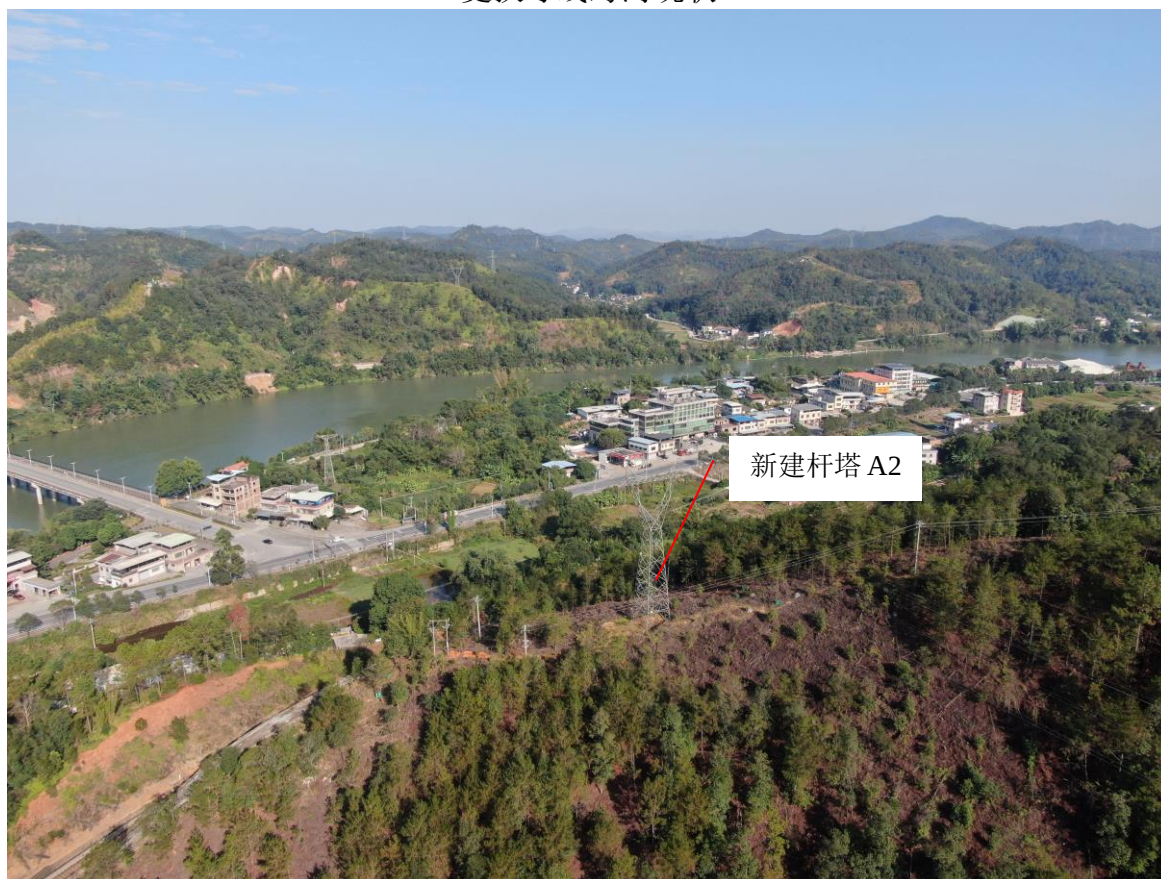
新建杆塔 A2 现状
