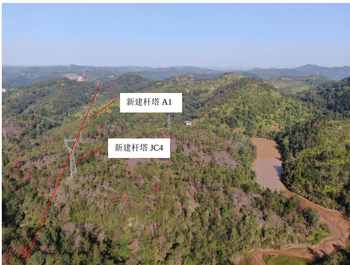
新建杆塔现状
