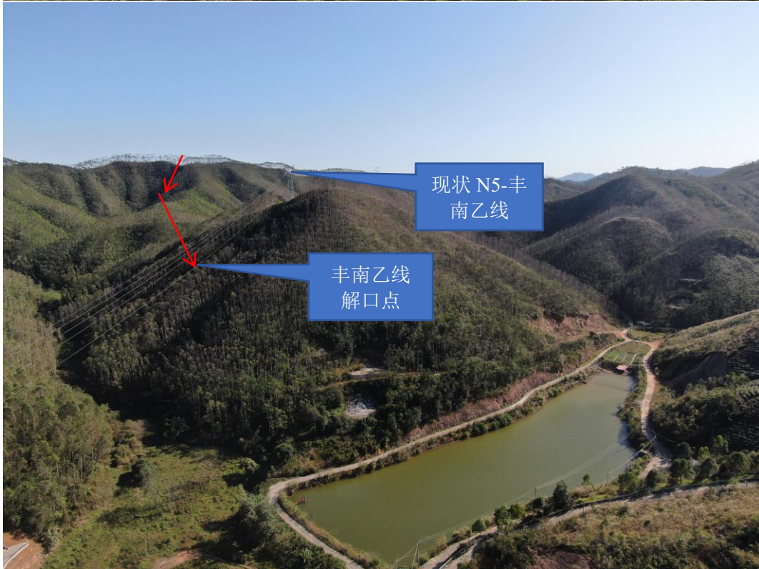
架空线路沿线地形地貌
