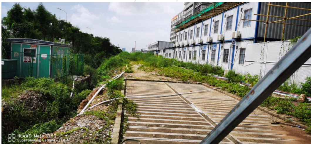
新环站站前政府建设电缆管沟
