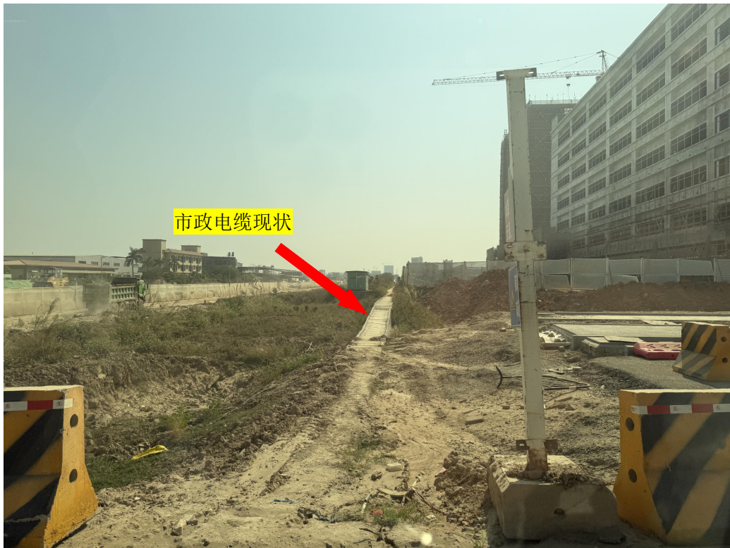
市政电缆沟现状
