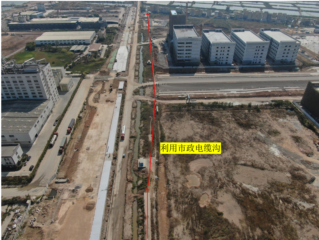
市政电缆沟现状
