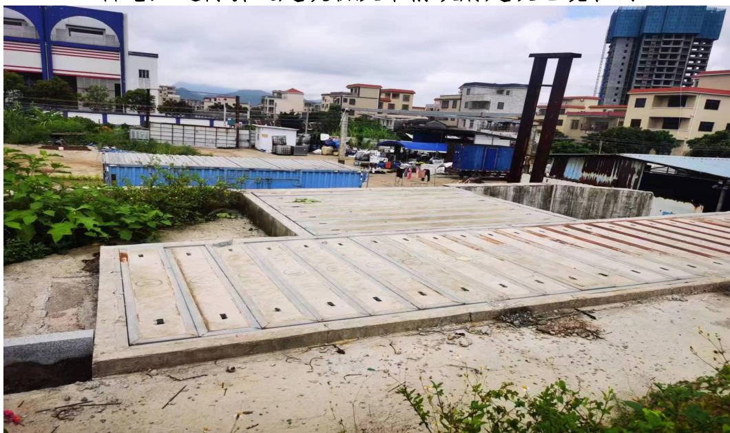
科港大道待拆近建筑物及站前政府建设电缆管沟
