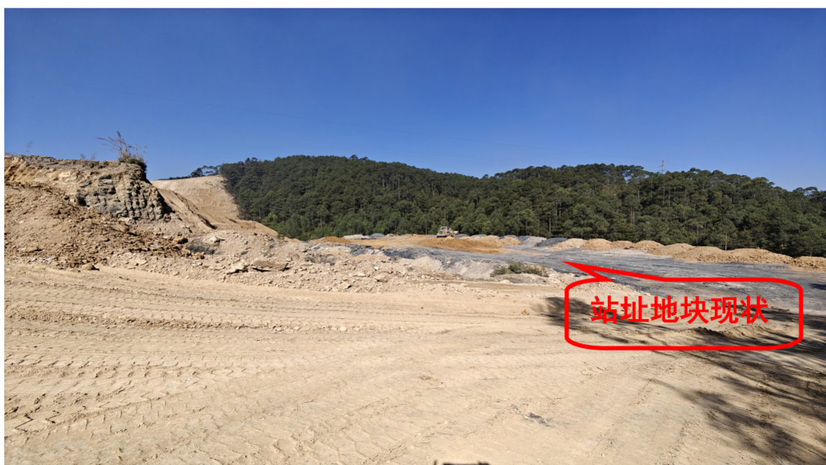
110kV乐干站站址现场照片（园区正在进行场地平整）
