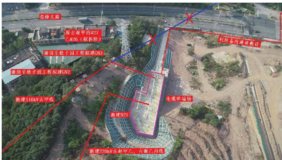
在终端场架空转电缆沿莞樟东路预留电缆通道走线（莞樟东路南面）情况
