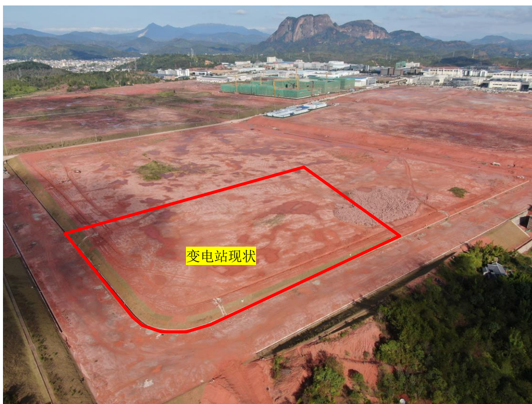
110kV 理塘站现状
